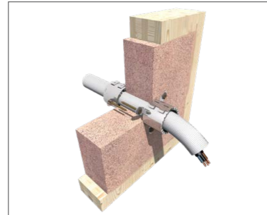
Leidingen en kabels van elektrische installaties afgedicht met RORCOL AV60
